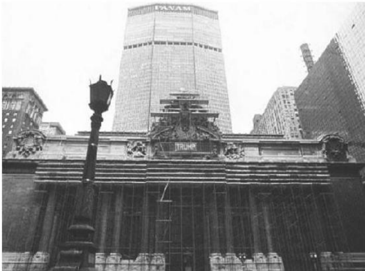
42街区中央车站的修复工程
